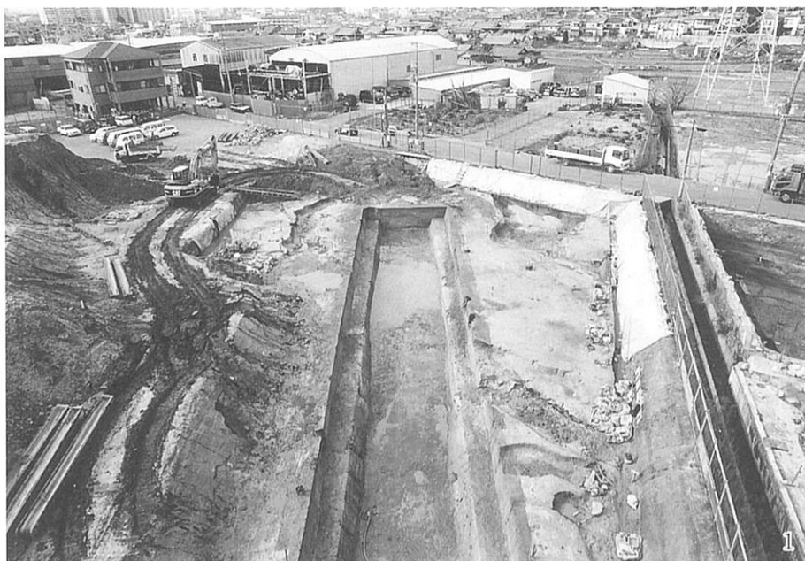
1. 確認トレンチ2 全景 (南から)
