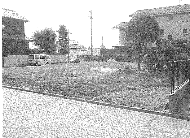
写真1 着手前近景（北西から）
