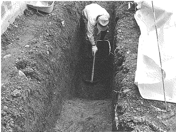
写真11 SD02掘削状況
