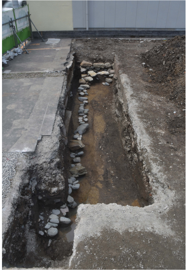
石組2基底部 (東から)
