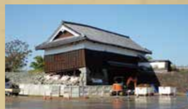
石材回収作業完了（一部）
