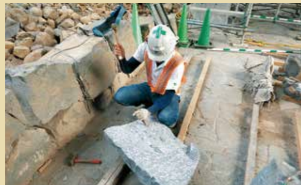
交換石材作成作業（石材細部の加工）
