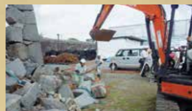
石材回収作業
