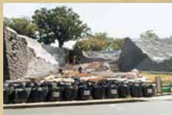
崩落石垣の安全工事
