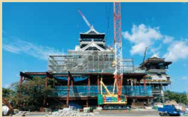
H30.9.5 天守閣工事 東より
