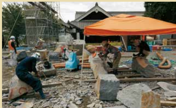
交換石材作成の様子
