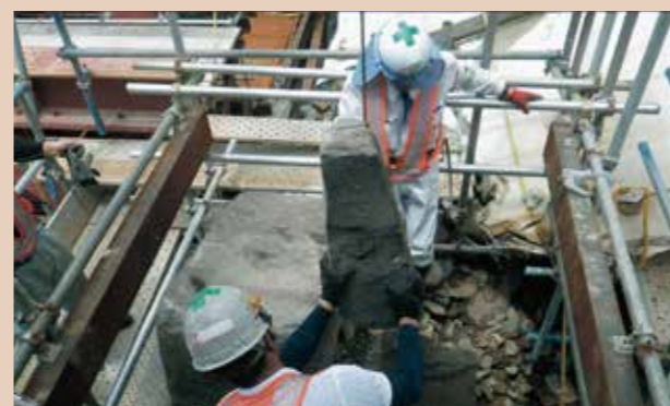
一本石垣解体
