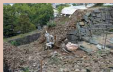
石材回収作業
