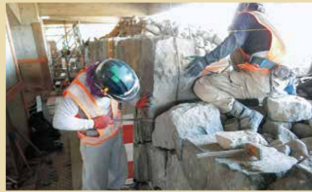
大天守台石垣穴蔵石積み作業
