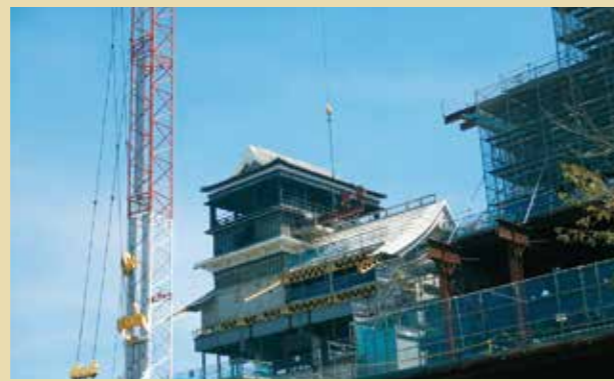
H30.8.29 天守閣工事 西より
