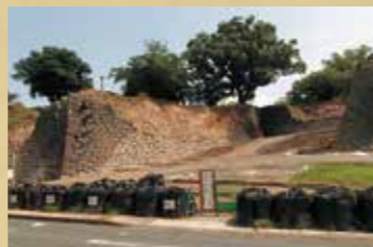
石材回収作業完了
