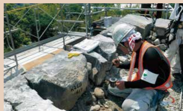
解体石材の番号付け
