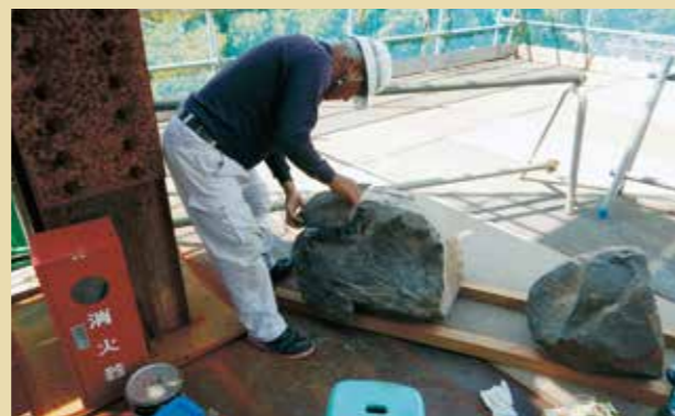
破損石材補修作業（破片の接合）
