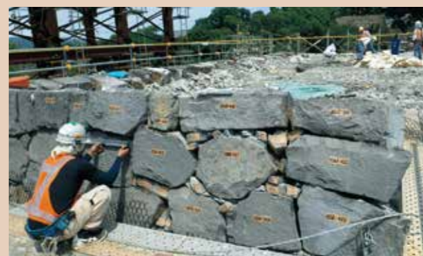
石垣解体前の基準線書き
