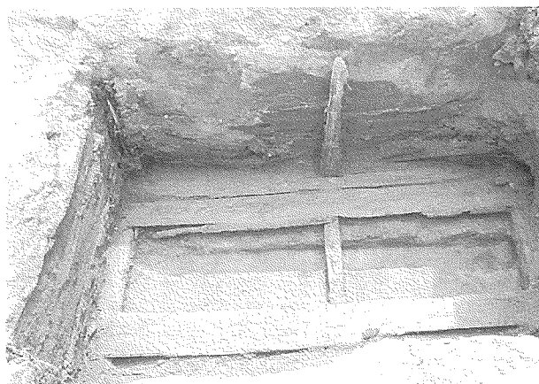
写真20 動いた床板材を取り除いた状況 (西から)
