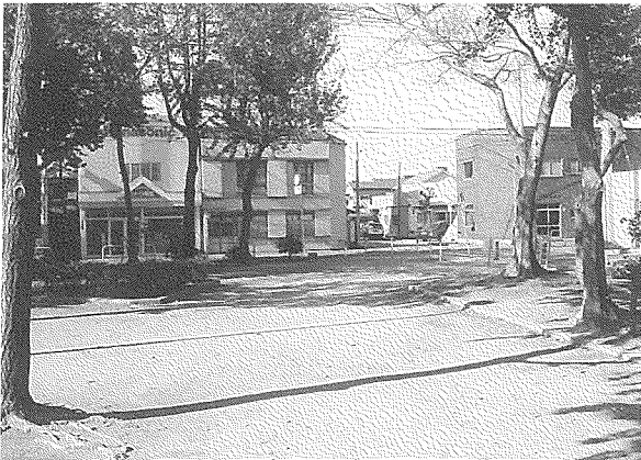
写真47 調査前状況(南東から)
