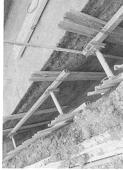
写真 5 測点 39 状況 (北西から)
