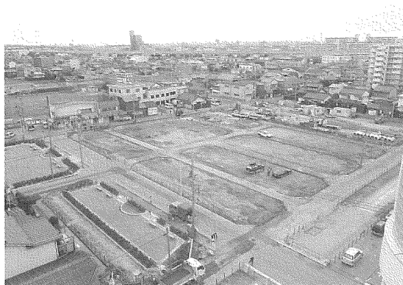
写真2 調査地点付近状況 (北西から俯瞰)
