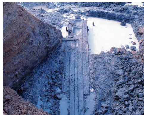
図2-1-11 延永ヤヨミ園遺跡出土木樋 九州歴史資料館提供
