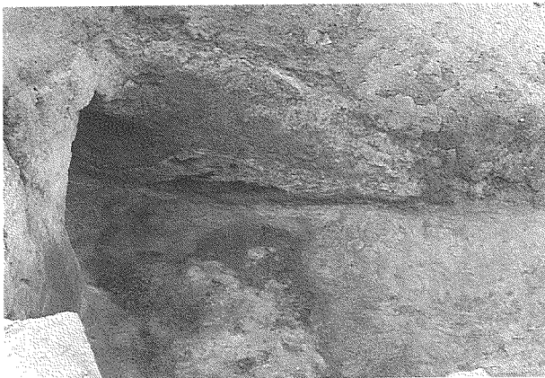
写真39 燃焼室床面および右壁
