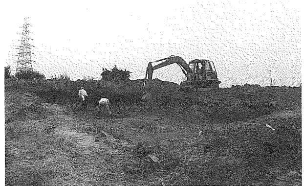
写真8 北南休地区表土掘削
