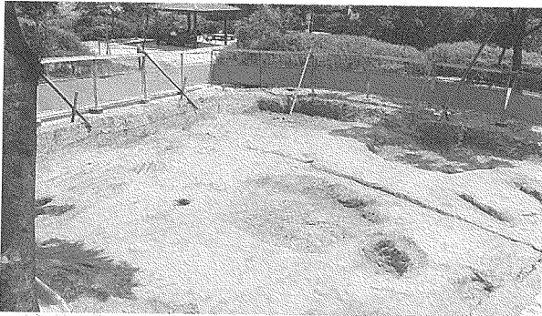
トイレ予定地全景
