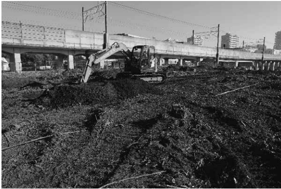
向山遺跡 j 地点トレンチ掘削状況
