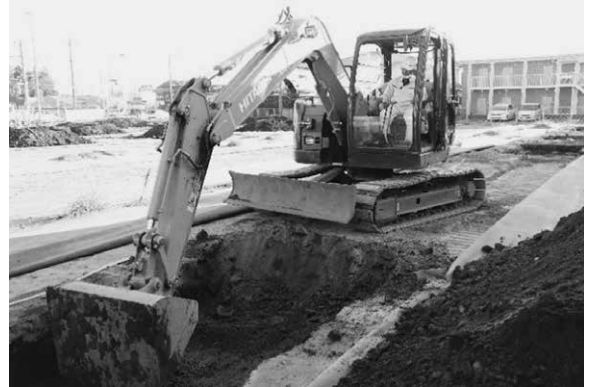
殿内遺跡 j 地点トレンチ掘削状況
