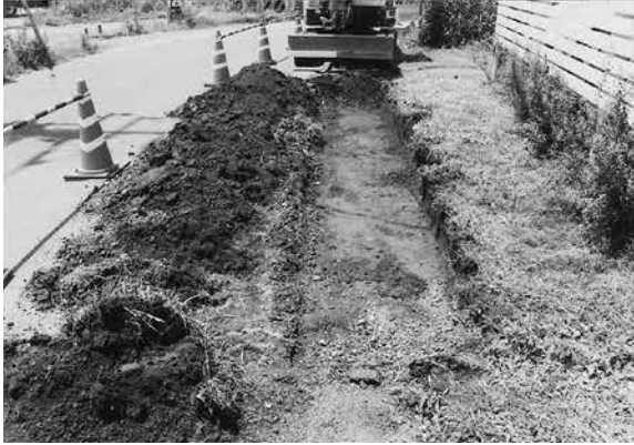
吉橋新山遺跡 a 地点 2T 完掘状況
