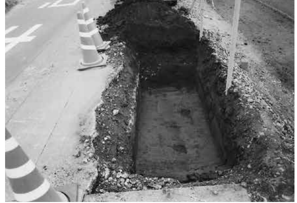
吉橋新山遺跡 a 地点 6T 完掘状況
