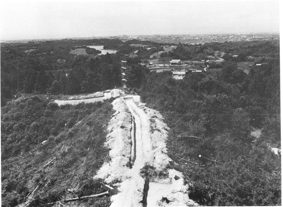
b. 第1、第2トレンチ全景（南南東から）
