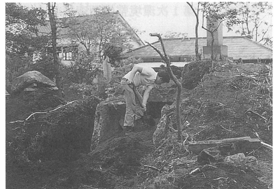
挿図写真10 石室埋め戻し風景（2）
