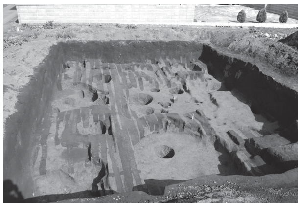
写真 24 調査区完掘状況 (西から)
