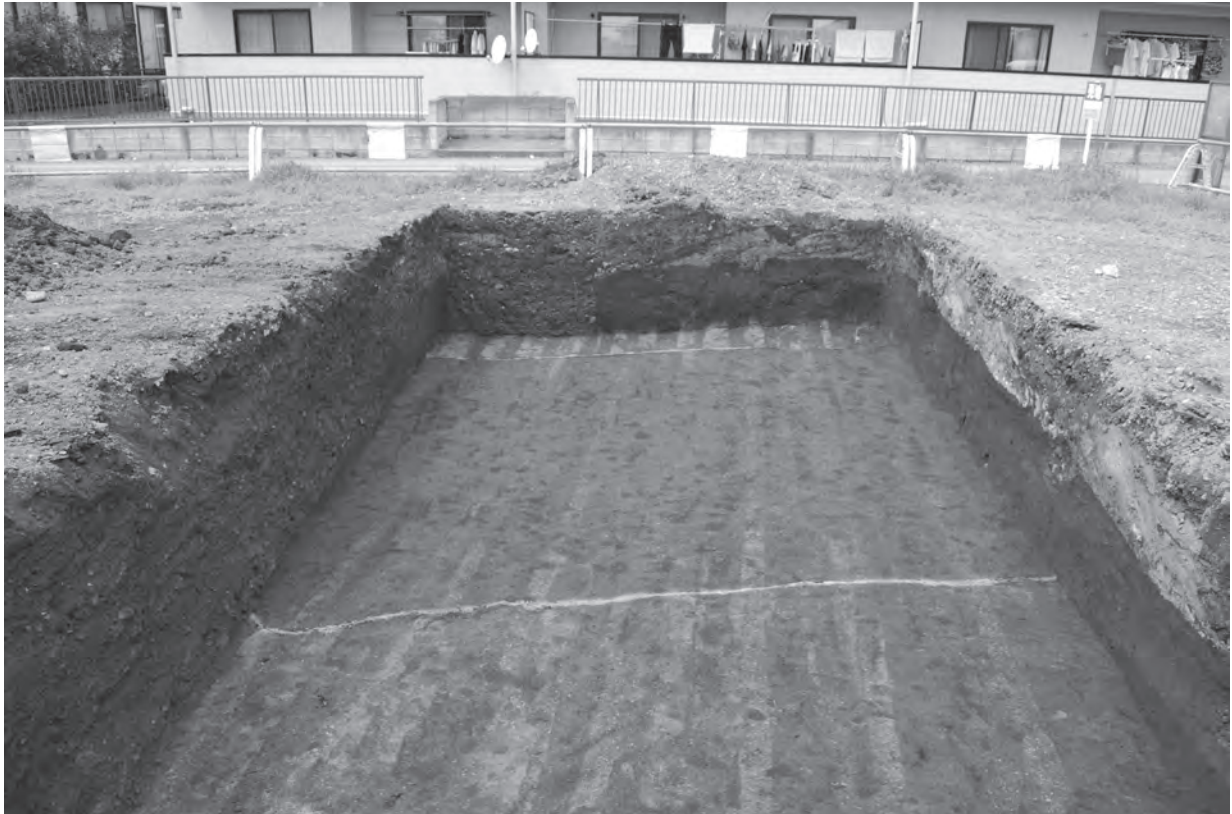
写真5 SI01 検出状況 (南から)
