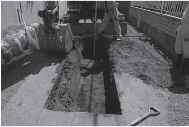
写真 18 1区掘削状況（西から）
