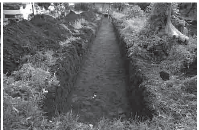
写真7 トレンチ1第1号溝跡検出状況(北から)
