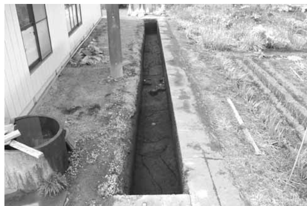
5区西側全景（東より）
