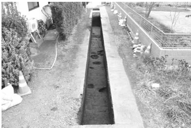
4区全景（東より）
