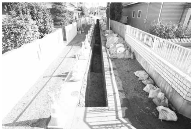
1区全景 (西より)
