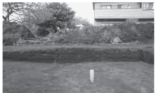
トレンチ土層堆積 (南から)
