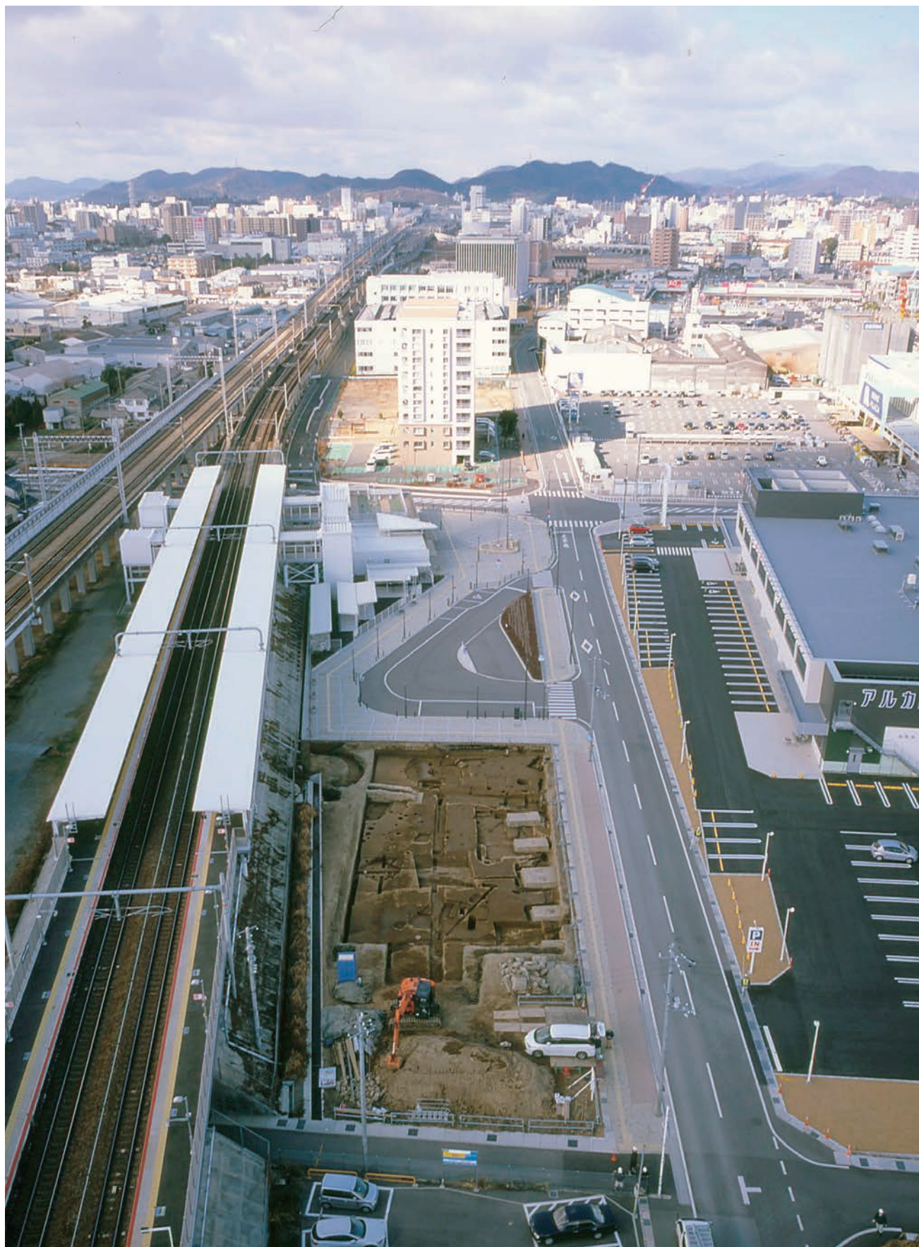
写真18 第18次 調査区近景(東から)
