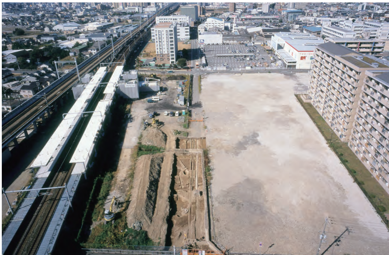
写真3 調査区と建造中のJR東姫路駅(東から)
