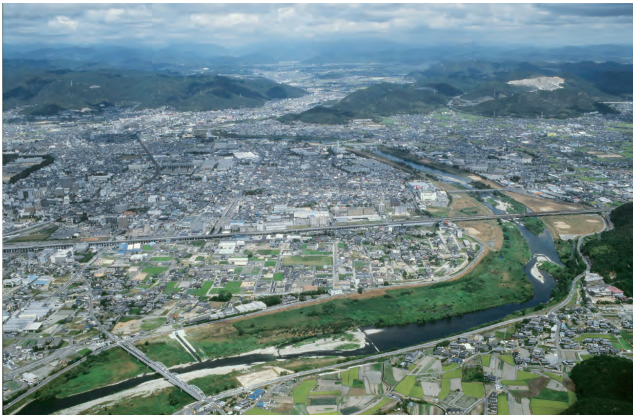
写真1 調査地遠景(北から)
