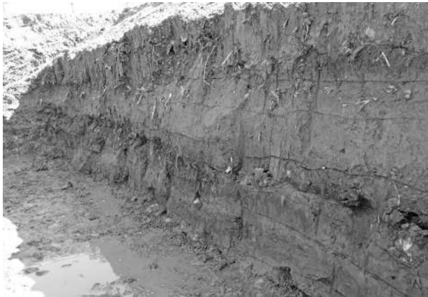
3 調査地 南壁断面
