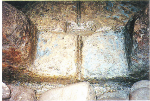
109 7号横穴墓 玄門部付近の排水溝（南から）
