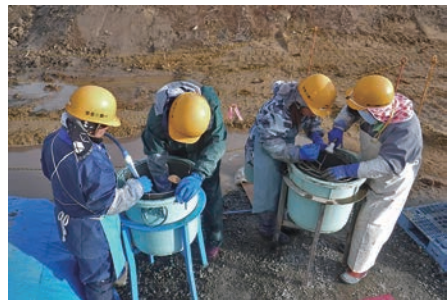
写真18 土壌洗浄作業
