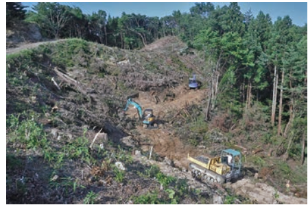
写真7 伐採木搬出作業
