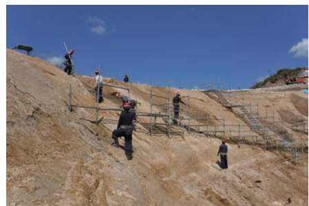
写真9 足場組立作業
