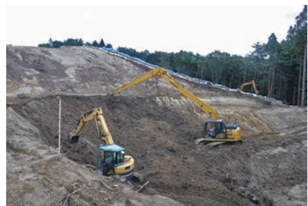
写真8 表土掘削作業
