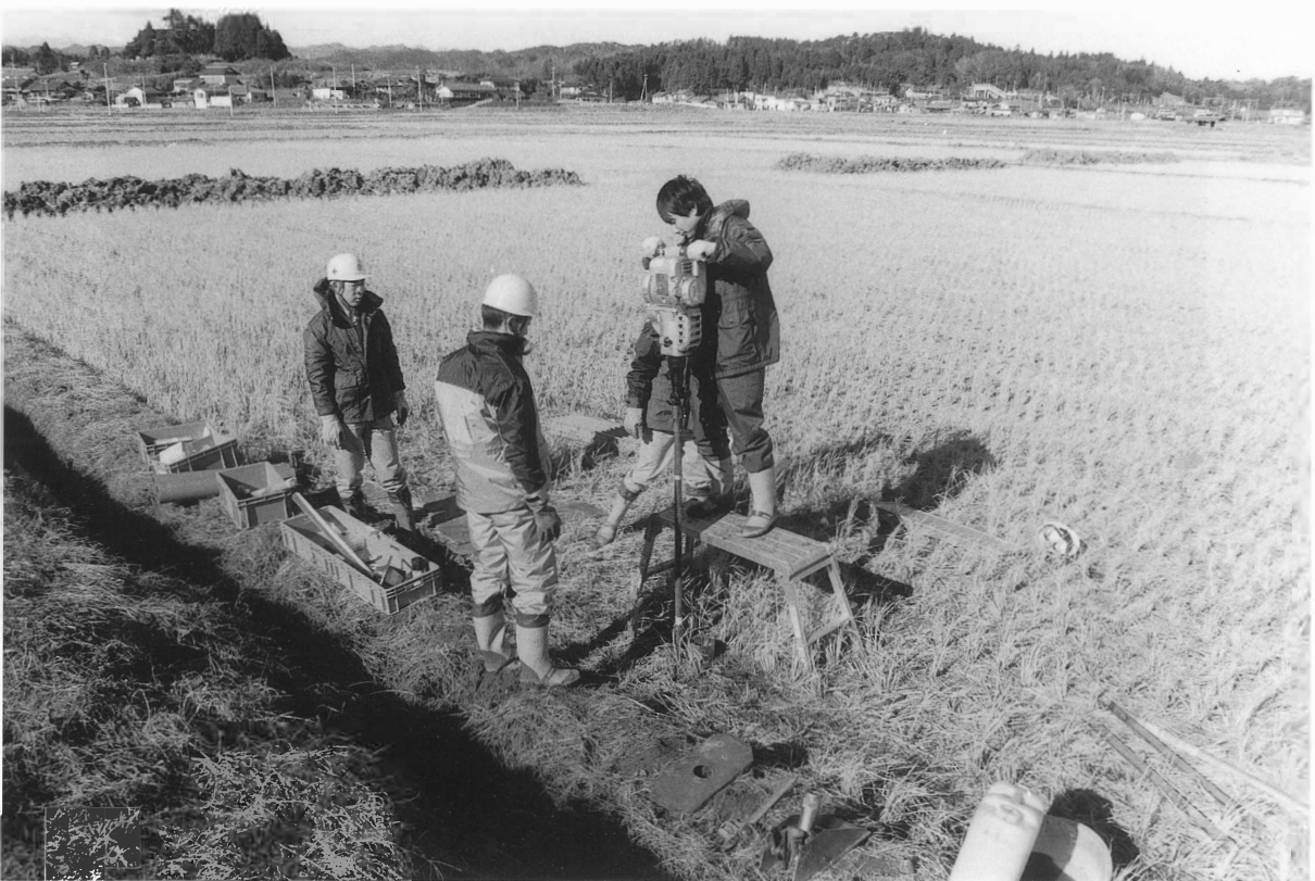
ボーリング調査
