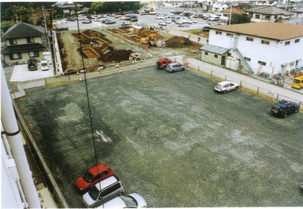
1 B地区全景 (南東から)
