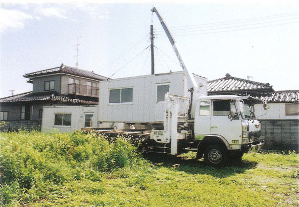
7 現場小屋設置状況（1）
