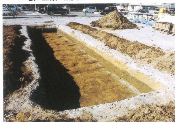
3 1 T全景 (南東から)
