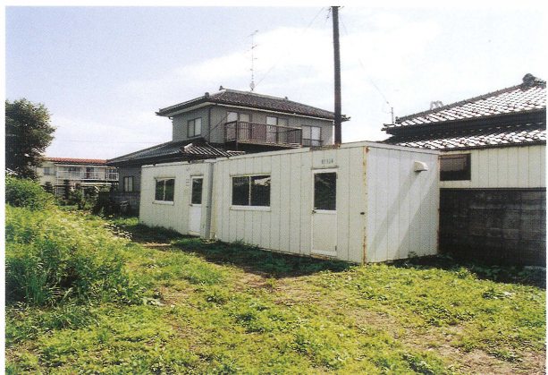
8 現場小屋設置状況（2）
