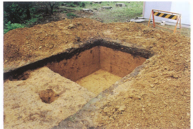
6 1 Tテストピット（南から）
