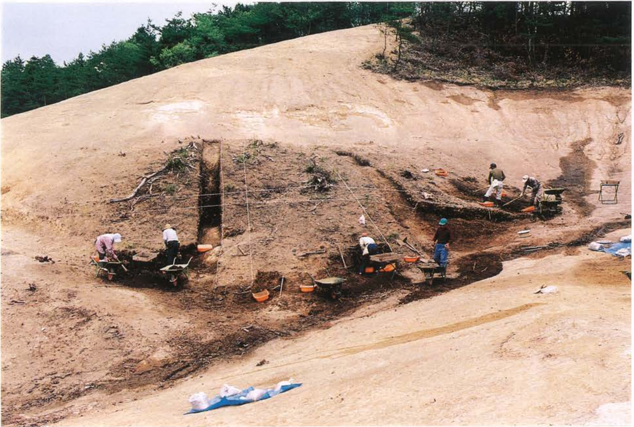
1 1号廃滓場 作業風景(1)
