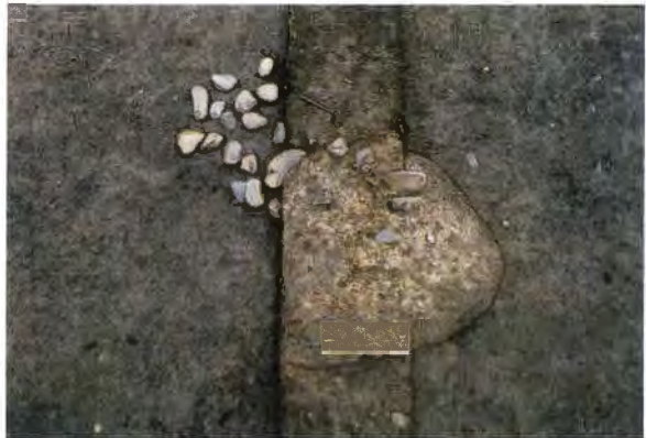
写真30 SB3a・b 礎石据え付け地業・根固め (西第2柱列北第3柱)
