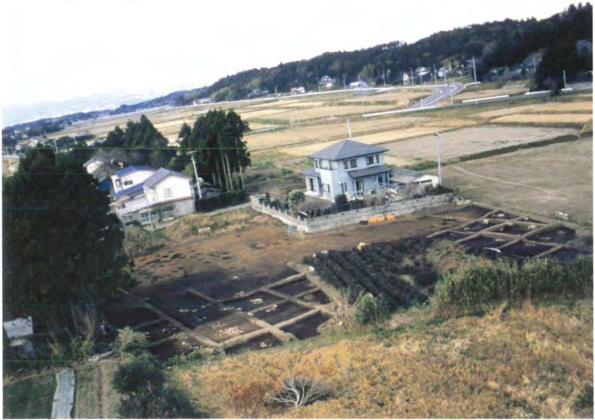
写真15 A地区近景（南東から）
