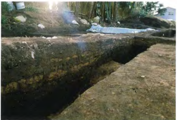
写真34 SB3c 地業土層断面 (A-A'セクション)
