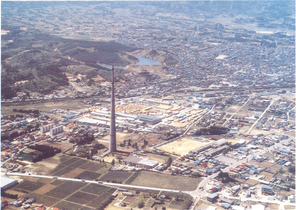
170 無線塔のある風景（解体前）
