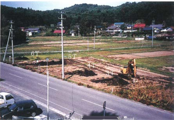
68 3～6号トレンチ (南東から)
