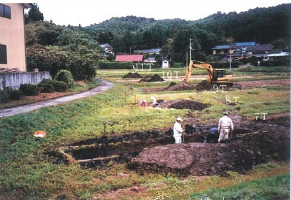
70 7～11号トレンチ (南東から)
