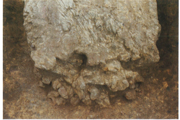
70. 東側粘土塊 崩壊した小口面（西から）
