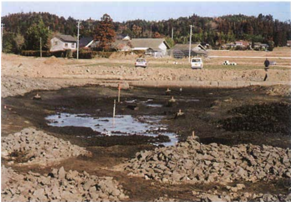
23 2号流路跡 (南から)
