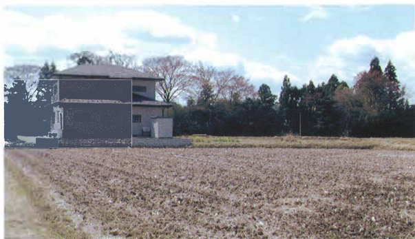
1 調査区近景（北から）
