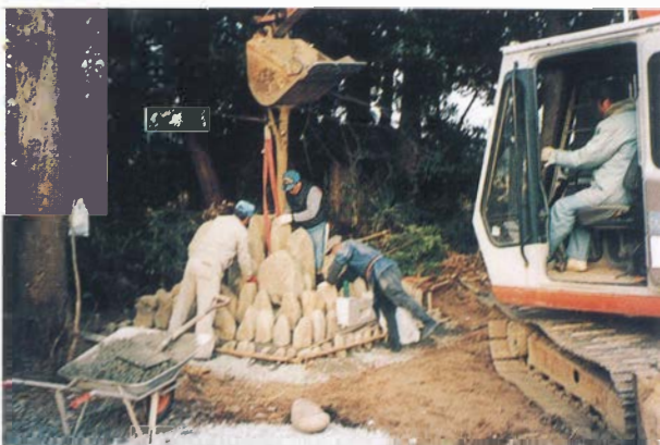
写真52 墓石塔建設作業 墓石を積み上げる
