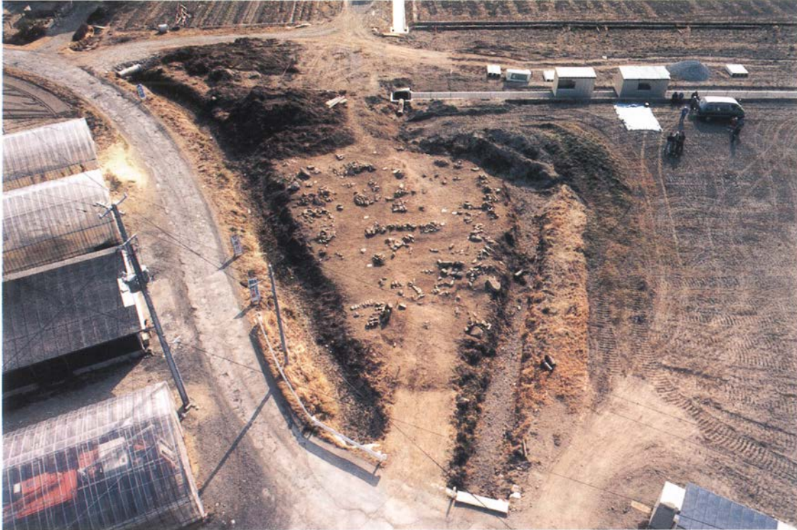
写真17 表土除去後全景(北から)
