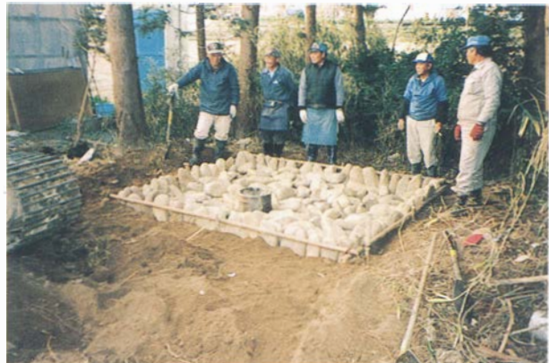
写真51 墓石塔建設作業 中央に骨壺を置き、礫は根石に使用
