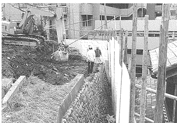
図3 擁壁工事立会風景
