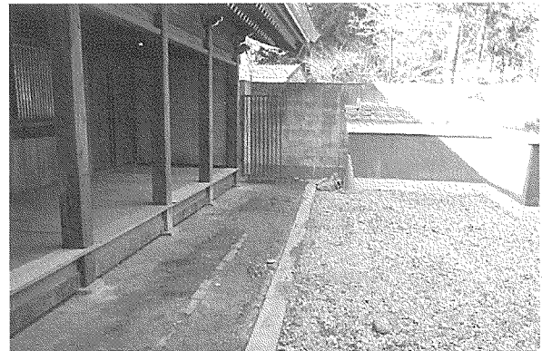
写真2 2区調査前状況(東から)
