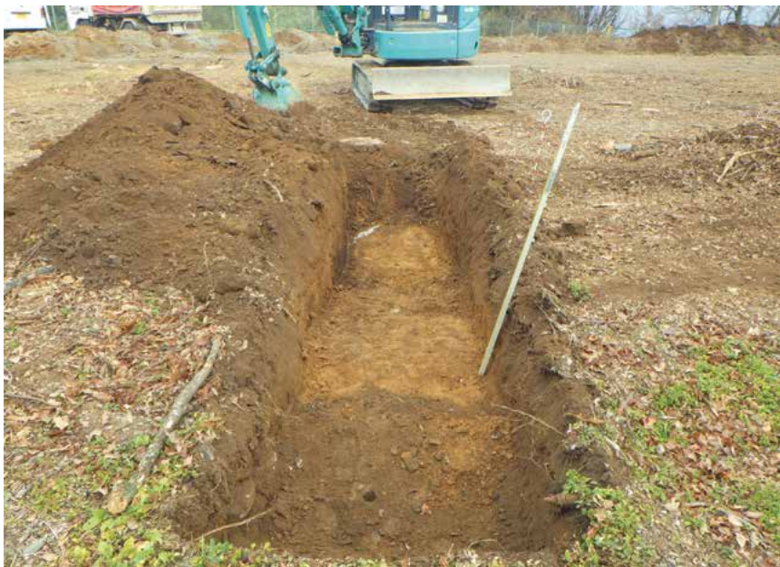
古城城跡トレンチ 3 全景 および堀 1 検出状況
