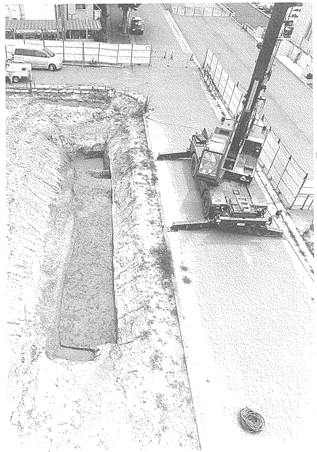
写真4-3 14次2区 (工-2区) クレーン撮影風景
