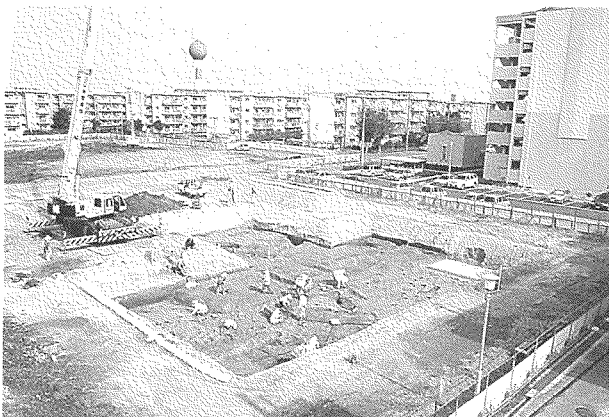
写真2-11 ク (14次6) 区空撮準備 (南西から)
