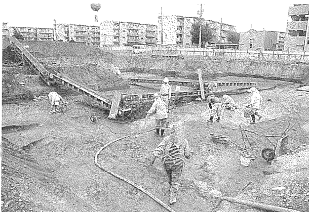
写真2-9 ク (14次6) 区排水作業 (南西から)
