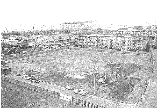
写真2-1 13次（工-1区）表土掘削（南東から）
