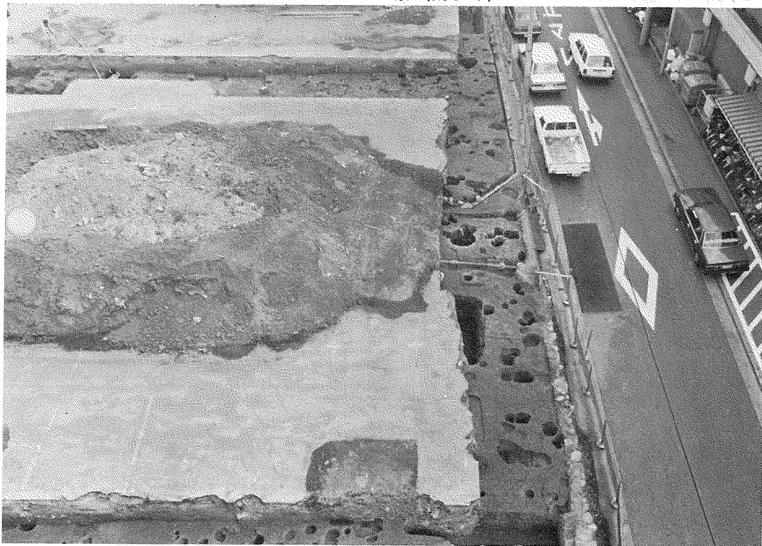
2. 南トレンチ (西より)
