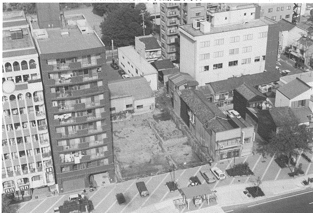
調査地全景（南から）
