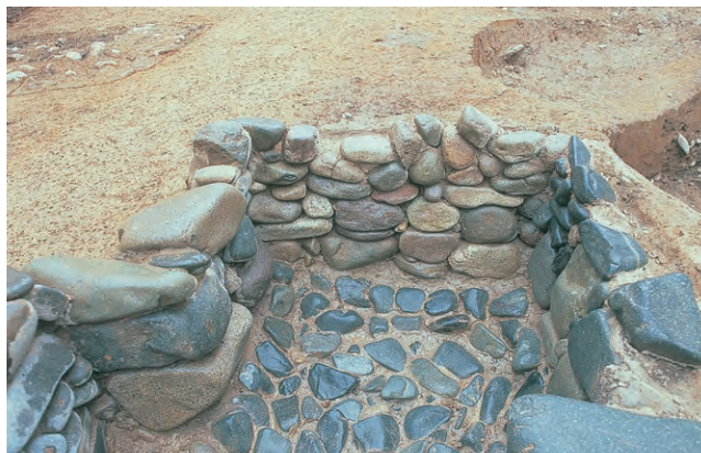
写真 22 1SK218南面石積み状況（北から）
