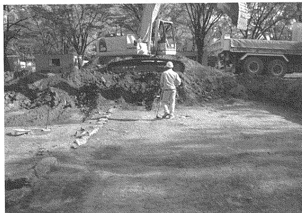
写真5 調査状況(表土除去)
