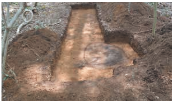
写真 17 9 T 調査状況
