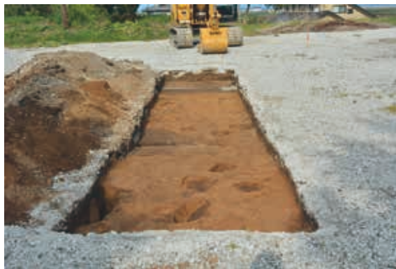
写真 49 1 T 調査状況
