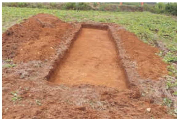
写真 46 6 T 調査状況
