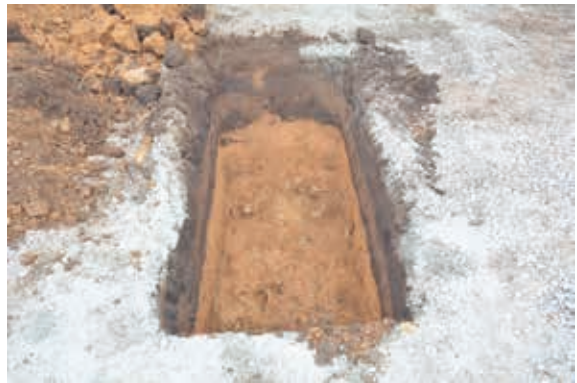
写真88 2T調査状況
