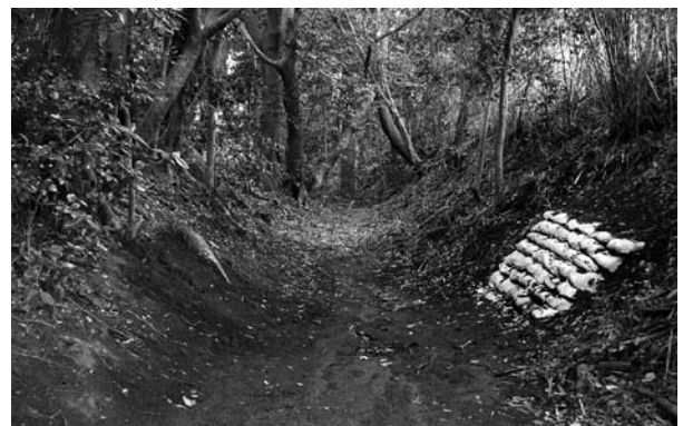
埋め戻し完了
