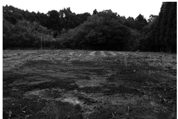
埋め戻し完了
