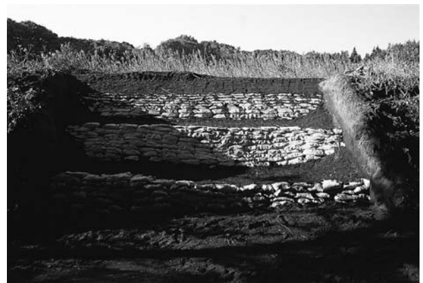
虎口(南側) 埋め戻し完了
