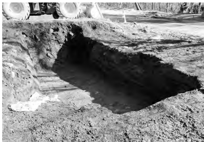
6 1区1面 土層断面I (西から)
