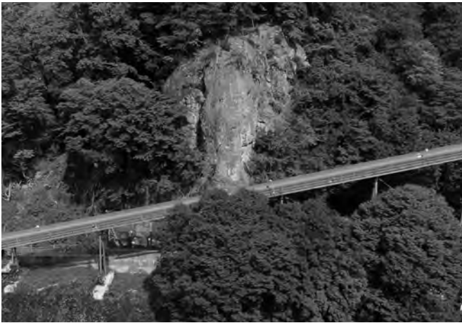
2 石畑 I 岩陰全景(南より)
