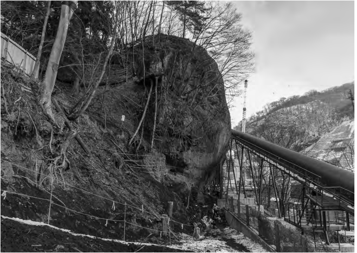
1 B区北岩張り出し状況(西より)
