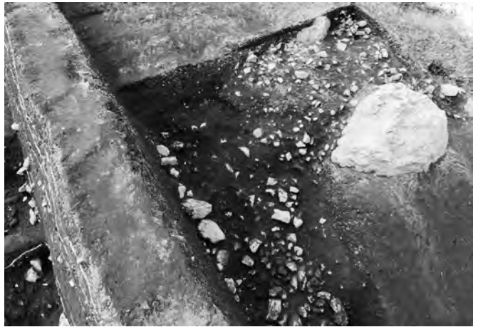
6. A区中央部2面土石崩れ石垣(南より)
