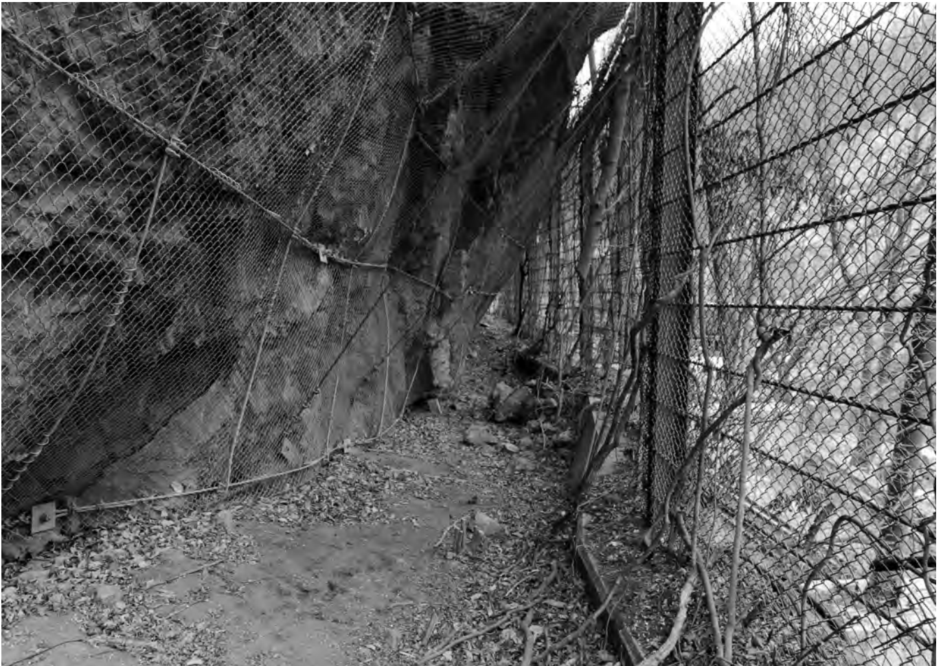
2 B区北調査前状況(西より)
