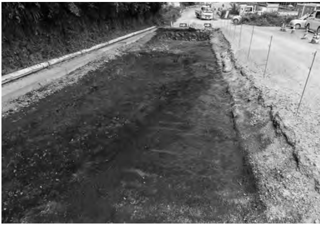
1 A区北東部(南西より)
