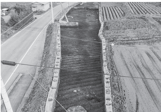
7 1区4号島 中央から西側全景 北西から
