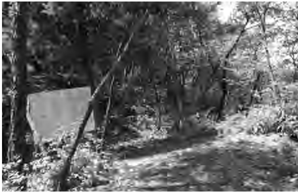
写真 197 曲輪 III 堀切 (南から)
