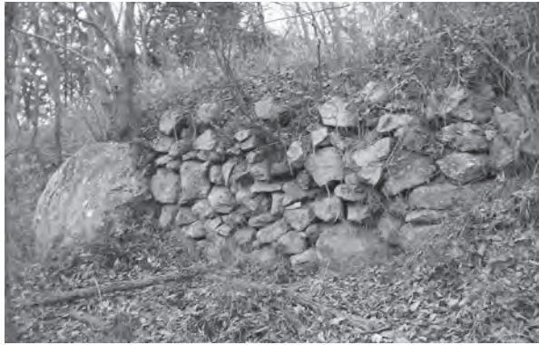
写真 117 曲輪 I 南西側石垣 (南から)
