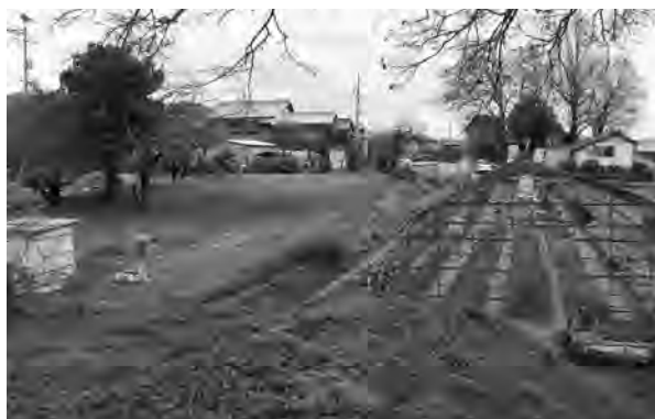
写真 183 北側土塁（北西から）
