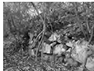
写真 95 長屋の下段と腰曲輪 間の石垣（北西から）
