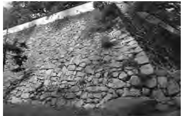
写真 163 本丸本段南東の石垣 （南東から）
