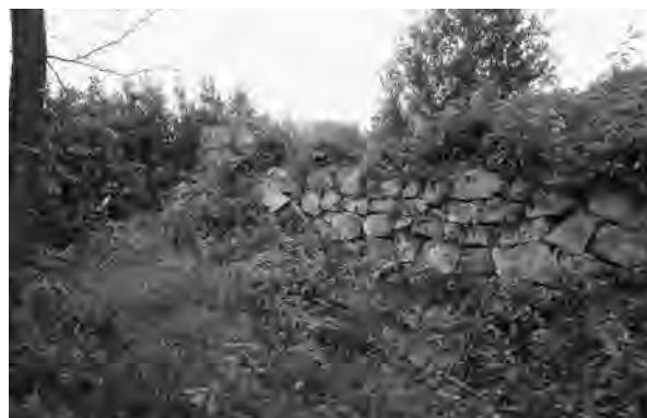
写真 35 曲輪Ⅰ南半土壇（北西から）
