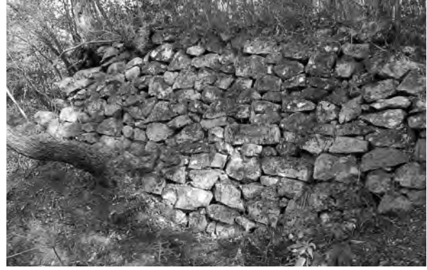
写真 223 三石城 (備前市)
