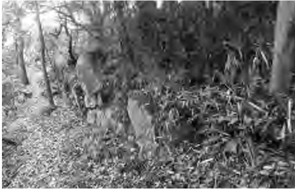
写真 157 曲輪 I 石積み (北西から)
