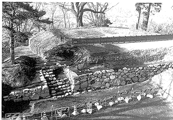
西櫓台基部石垣
