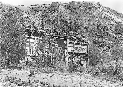
小串鉾山跡 変電所跡
