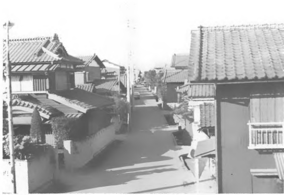
角淵地内の東ルート
