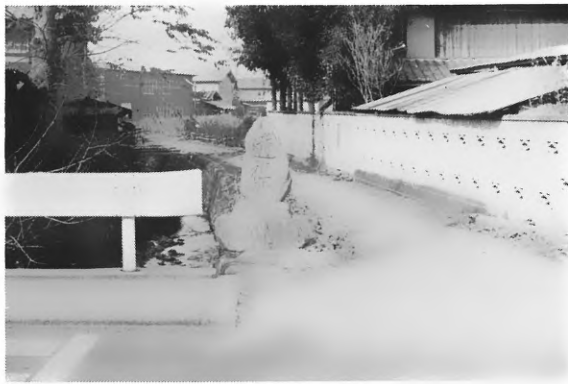
東平井信号機付近
