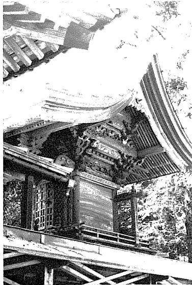
旧大杉社々殿(現榛東村新井)
