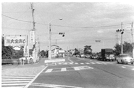
中豊岡より高崎方面環状道路との交差点 (右バイパス、左旧道)
