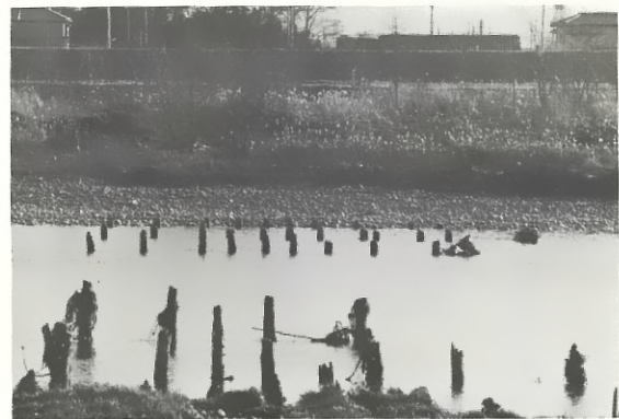
烏川木橋の橋杭 左岸（北側）より
