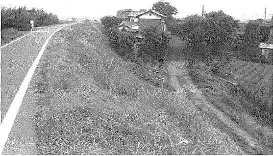
中島地内の中山道(左堤防、右中山道)
